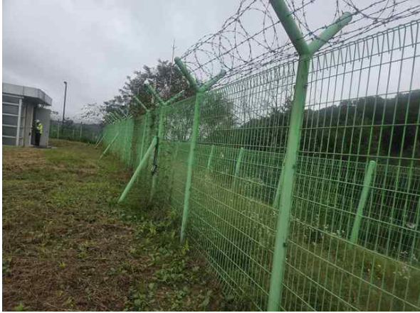
<안전 펜스 상태양호>
