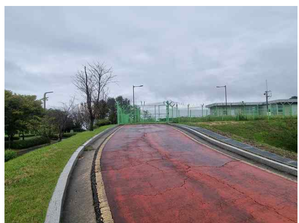
<진입로 포장 현황>
