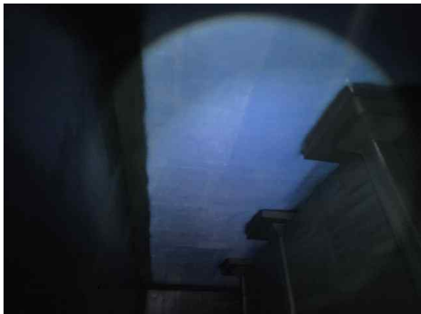
<배수지 2지 상부슬래브 상태양호>
