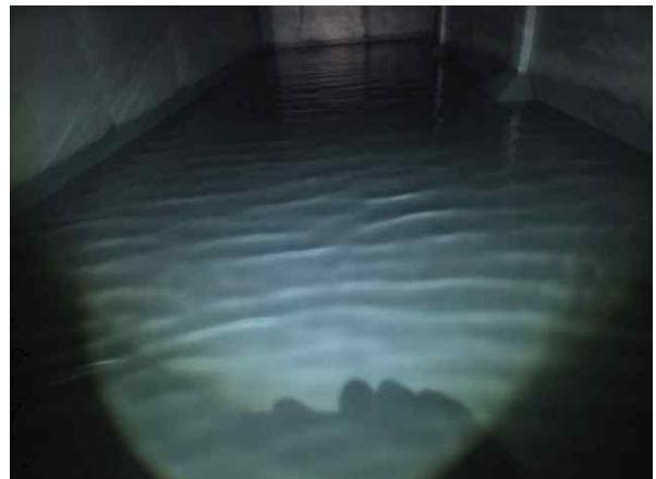
<배수지 2지 바닥슬래브 상태양호>
