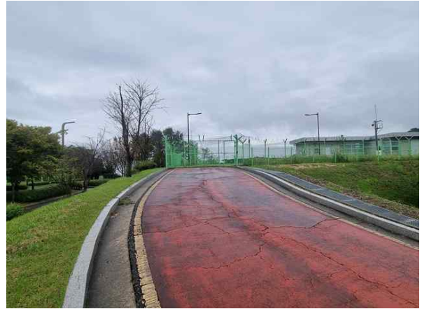
<진입로 포장 전경>
