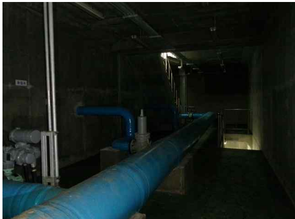
<통합유출밸브실 지하1층 전경>
