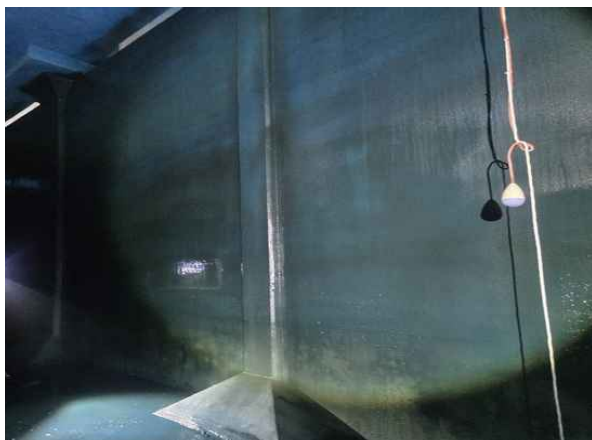
<배수지 1지 도류벽 상태양호>
