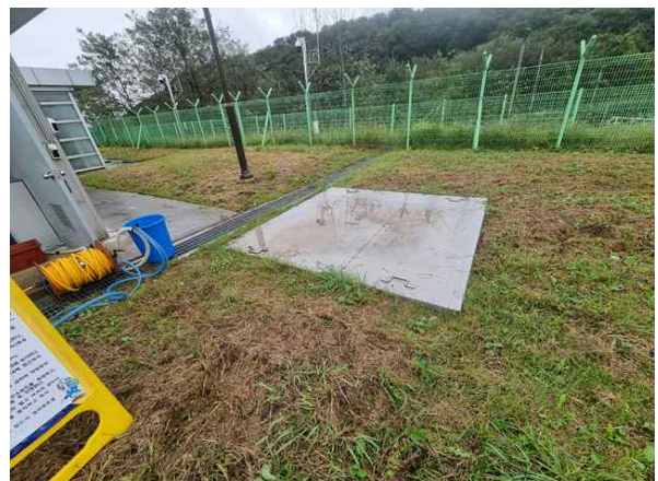
<장비 반입구 덮개 현황>
