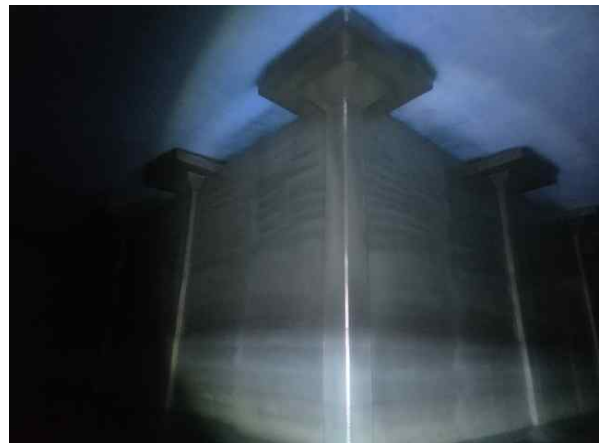
<배수지 2지 기둥 상태양호>
