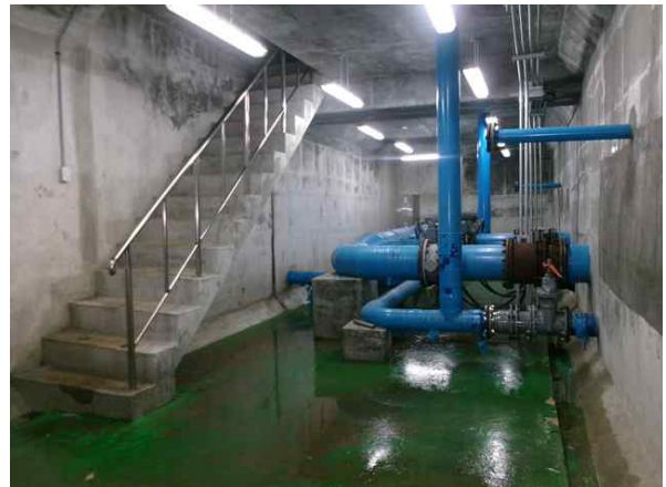
<유입밸브실 지하2층 전경>
