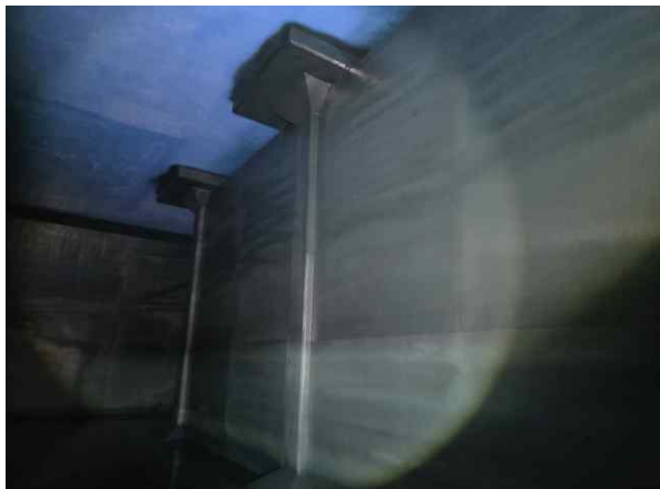
<배수지 2지 도류벽 상태양호>
