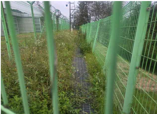
<배수로U 형 전경>
