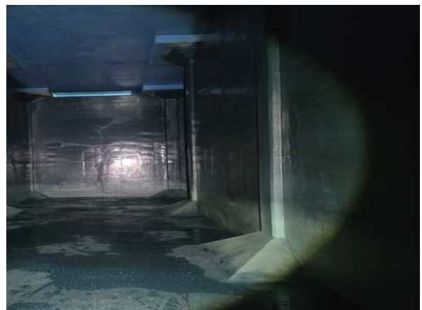
<배수지 1지 기둥 상태양호>
