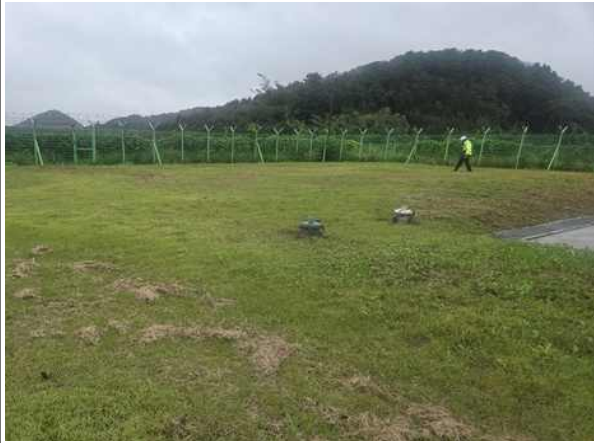
<외부 개별부재 외관조사>
