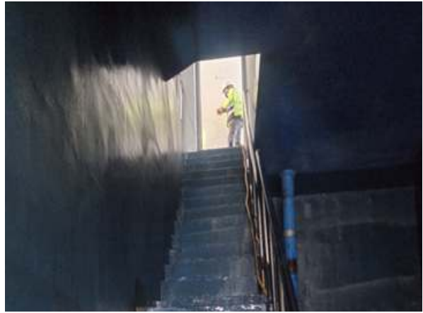
<내부 개별부재 외관조사>
